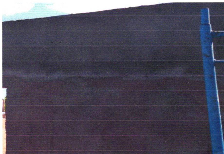
FOTO 8 – MASSA ÚNICA, PARA RECEBIMENTO DE PINTURA, EM ARGAMASSA TRAÇO 1:2:8, PREPARO MANUAL, APLICADA MANUALMENTE EM FACES INTERNAS DE PAREDES, ESPESSURA DE 10MM, COM EXECUÇÃO DE TALISCAS. AF_06/2014 (CASA EM EMPREENHIMENTOS) FCK=25MPA. AF_01_01/2017
