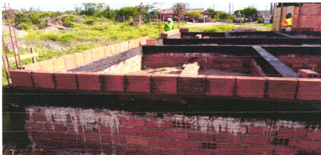
FOTO 01 – ALVENARIA DE VEDAÇÃO DE BLOCOS CERÂMICOS FURADOS NA VERTICAL DE 9X19X39CM (ESPESSURA 9CM) DE PAREDES COM ÁREA LÍQUIDA MAIOR OU IGUAL A 6M 2 COM VÃOS E ARGAMASSA DE ASSENTAMENTO COM PREPARO EM BETONEIRA. AF_06/2014
