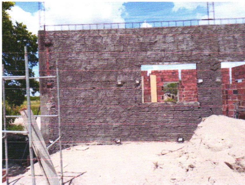
FOTO 05 – CHAPISCO APLICADO EM ALVENARIAS E ESTRUTURAS DE CONCRETO INTERNAS, COM COLHER DE PEDREIRO. ARGAMASSA TRAÇO 1:3 COM PREPARO EM BETONEIRA 400L. AF_06/2014
